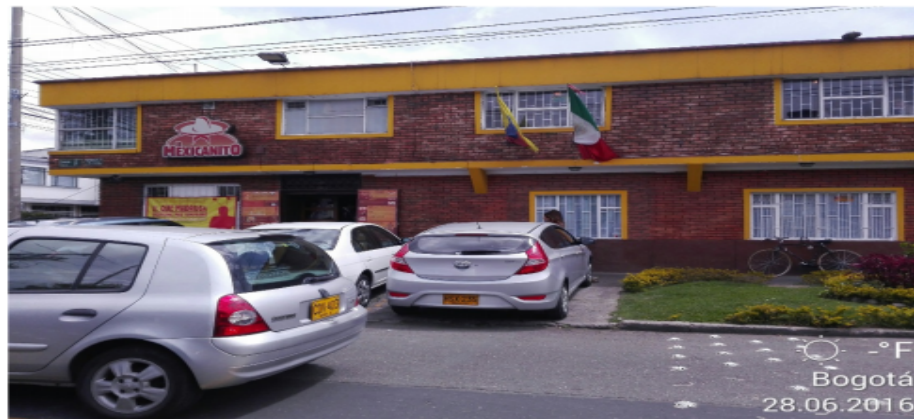
Fotografía No. 2: Panorámica del Aviso del establecimiento EL MEXICANITO S.A.S, ubicado en la Carrera 22 No. 87-09
